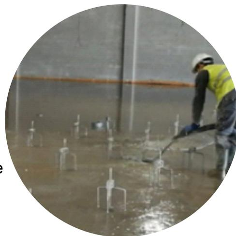
No aplicar el producto con riesgo de lluvia, ni heladas. Trabajar en temperaturas comprendidas entre 5°C Y 35°C. Dejar secar 24 horas antes de pisar la superficie y 7 días antes de la colocación de carga sobre la superficie.
